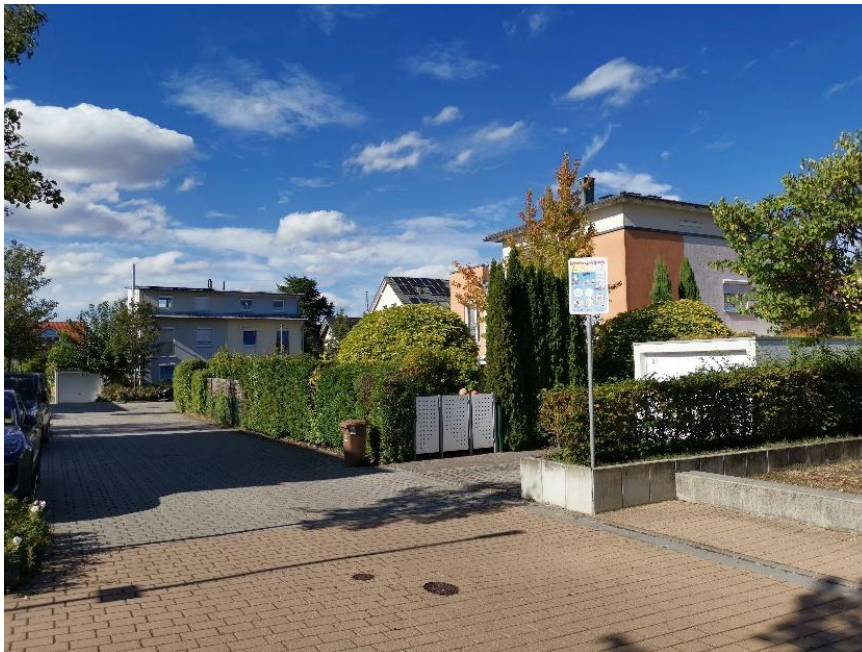
Abbildung 8: Ansicht der Gebäude in der Ringgartenstraße in Bensheim (Quelle: GGEW)
