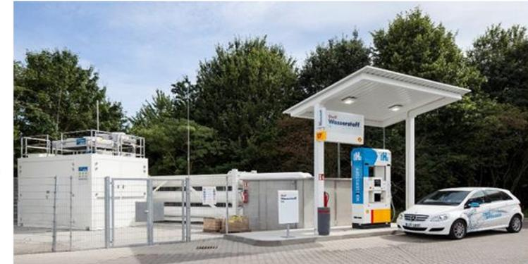
Aufbau einer H<sub>2</sub>-Tankstelle (Linde AG, 2018)
