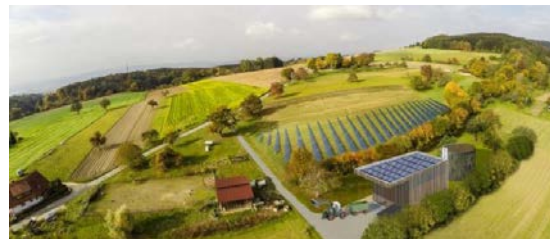
Solarthermie- kollektorfeld Wärmespeicher 250 MWh
